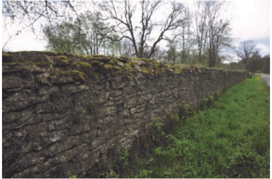
Ethe, mur en pierres sèches Photo : C. Cassimans
